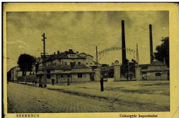
Cukorgyár irodaház és főbejárat
