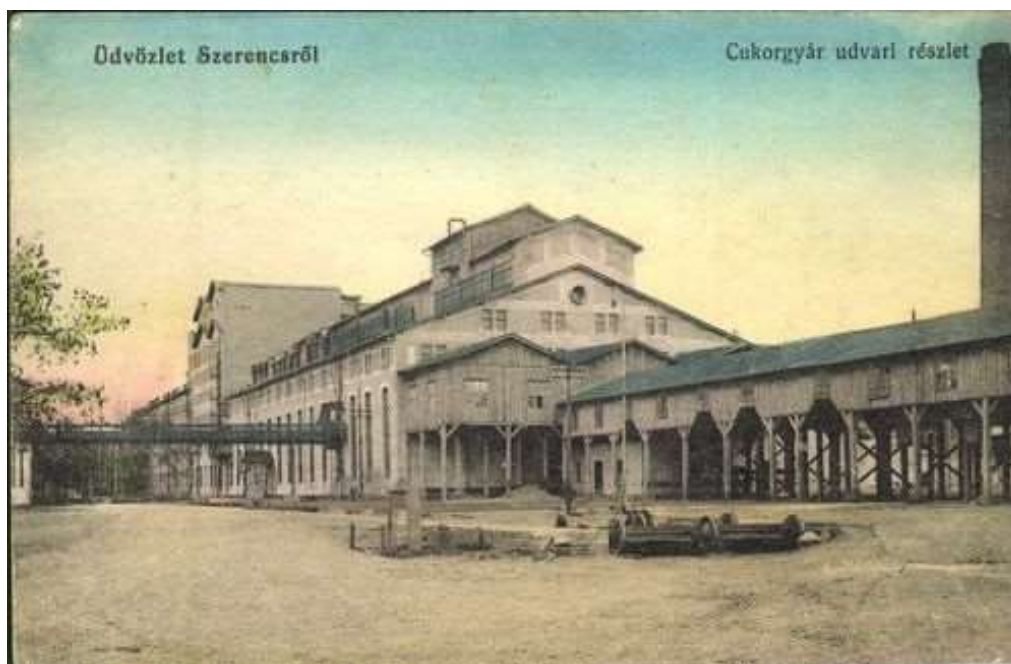
Cukorgyár gyártási főépület udvar felőli részlet
