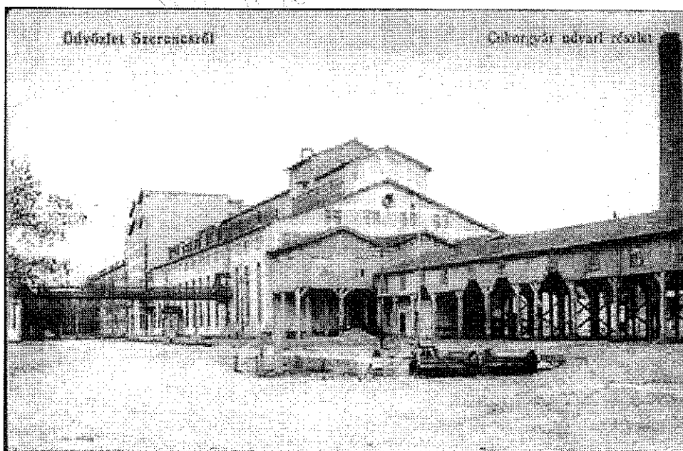
Cukorgyár gyártási főépület udvar felőli részlet
