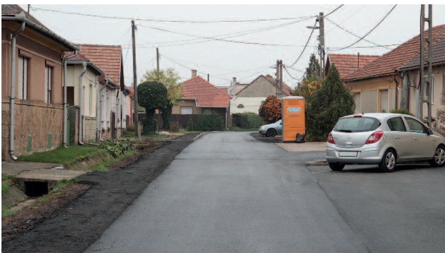
Az útburkolat felújítását megelőzően kicserélték az ivóvízcsatornát is.
