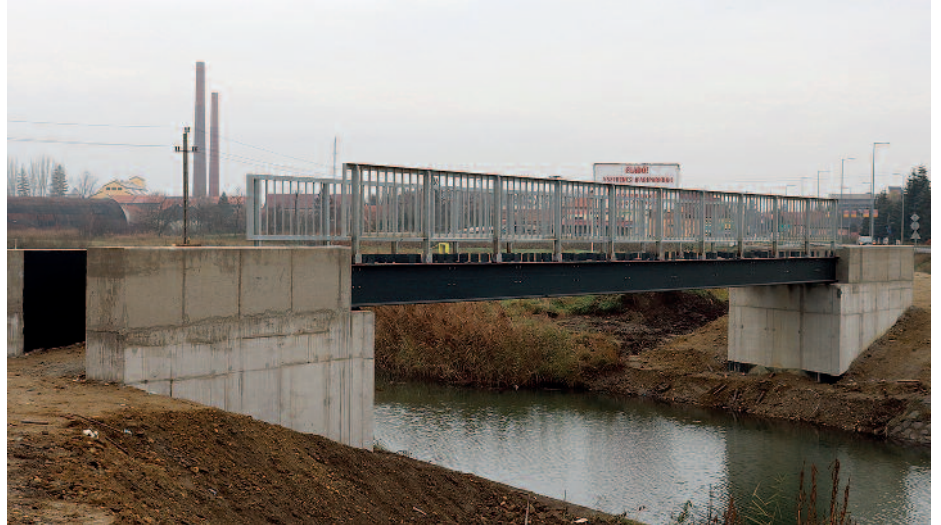
Helyére került a híd acélszerkezete.
