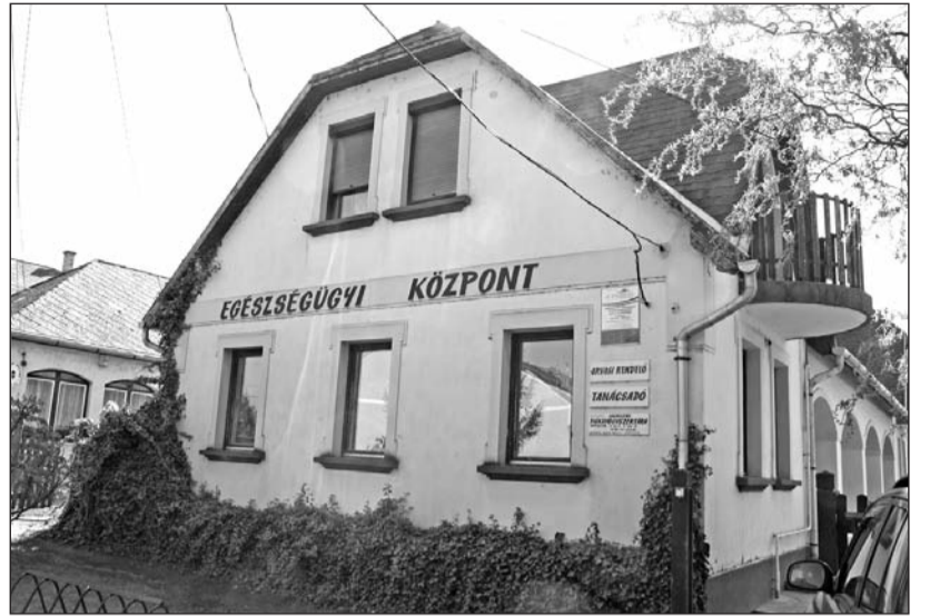
A felújítás már megkezdődött.
